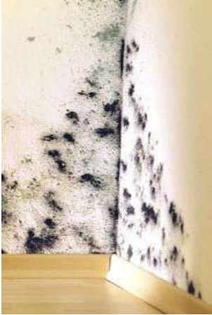
Şekil.3 Duvar üzerinde oluşan küflenmeler.
