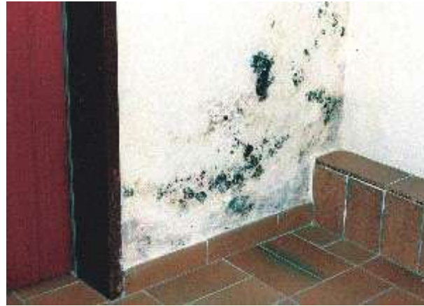
Şekil.3 Duvar üzerinde oluşan küflenmeler.
